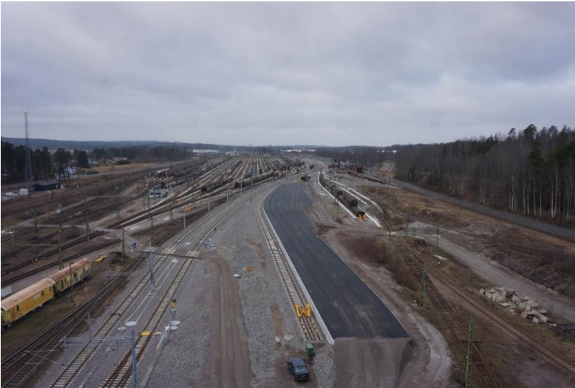
Figur 68: Befintlig "renoverad" lastplats för makadam.
